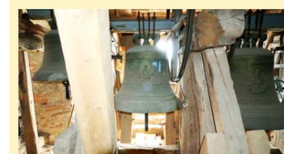
Am Donnerstag, 3. Juli werden bei unserem Kirchturm Schwingungsmessungen durchgeführt. Diese Messungen dienen dazu, eine optimale Platzierung des neuen Glockenstuhls aufzuzeigen.
